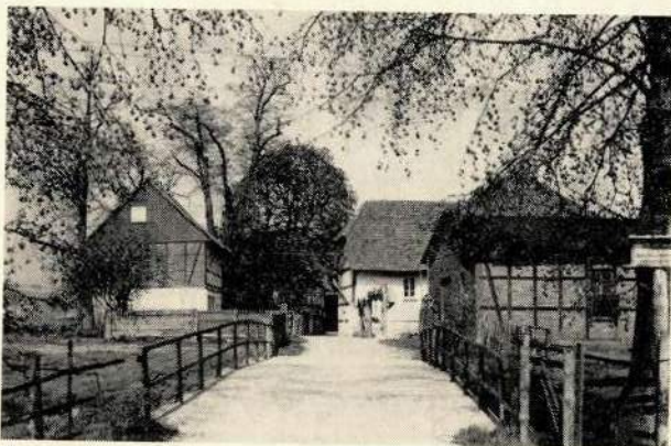
Einfahrt zur Leinemühle bei Northeim/Hann.
